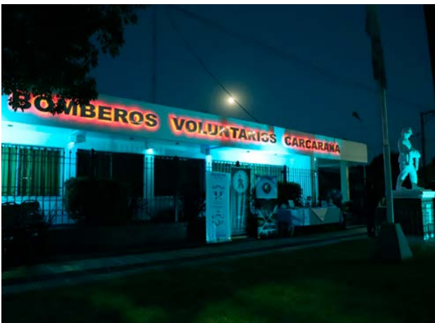
ACARDI - Carcaraña- Iluminación Edificio de Bomberos.
